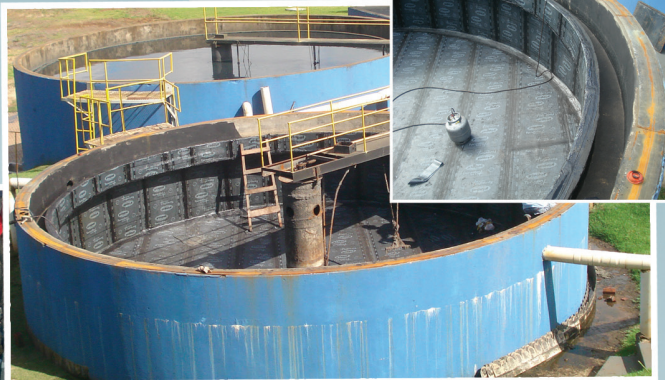
Aplicação de manta asfáltica em tanque
