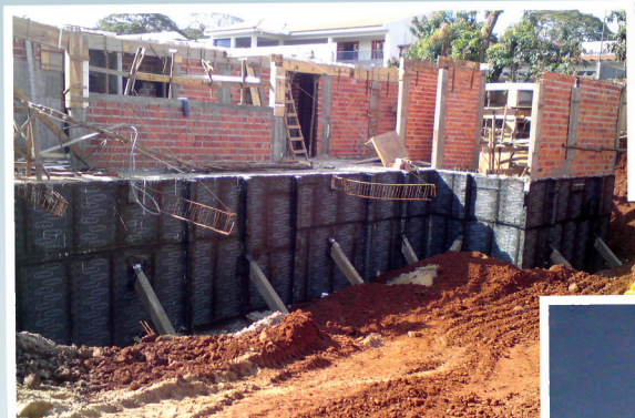
Muro de arrimo com manta asfáltica.
