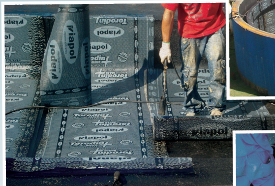
Técnica de aplicação de manta asfáltica
