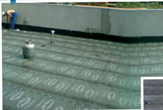
Manta asfáltica finalizada em laje exposta
