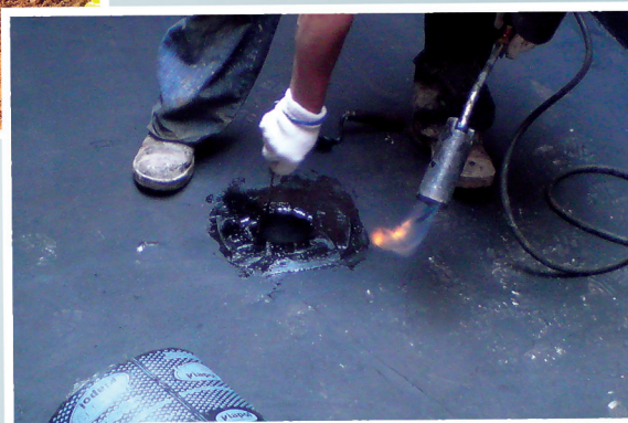
Metodologia de aplicação de manta em ralos
